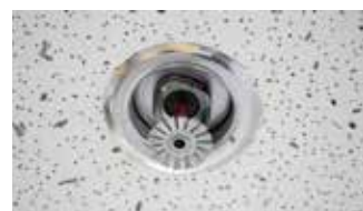
スプリンクラーヘッドとは スプリンクラーの床面に一番近い部分
