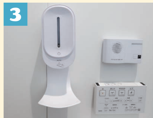
3 トイレ専用の便座除菌クリーナー(左) 気になる音や節水に効果的な擬音装置(右上)
