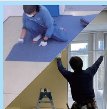
タイルカーペット / 間仕切工事
