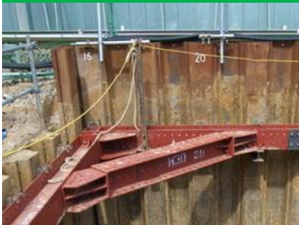
掘削・土留め工事
