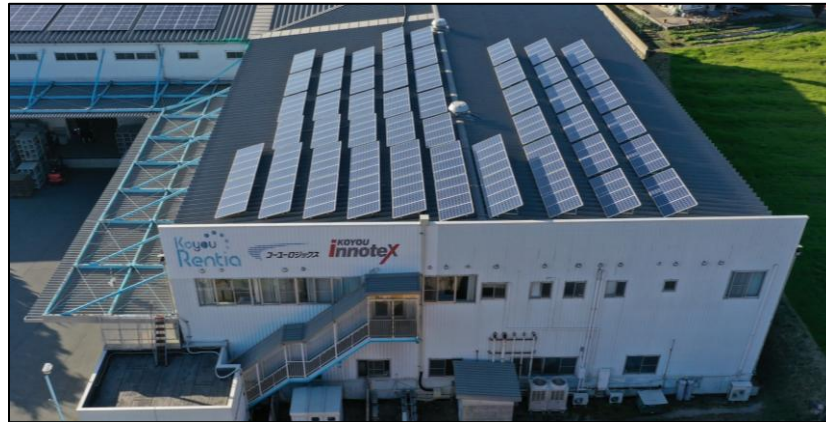
九州エリアセンター 屋上 リユースパネル
